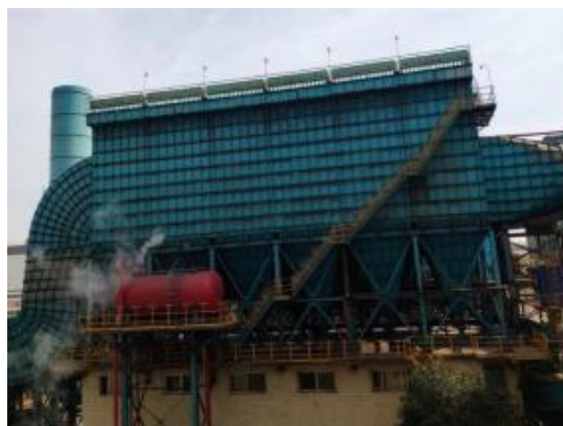
3200m 3 高炉出铁场袋式除尘器
