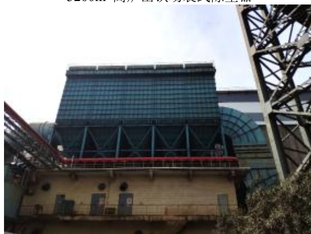
高炉矿槽袋式除尘器
