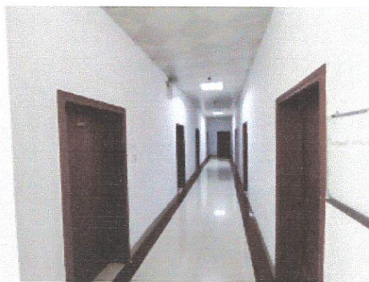
19、虹桥北路125号1号楼1楼西侧间
