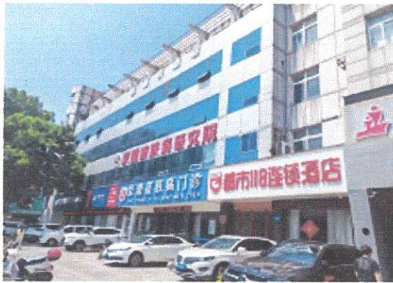
33、朝阳路75-1、-2门面房和75-1至-10的四楼、五楼房屋以及六楼的全部房屋
