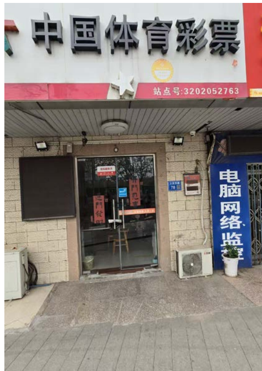
人民西路 78 号楼下一间
